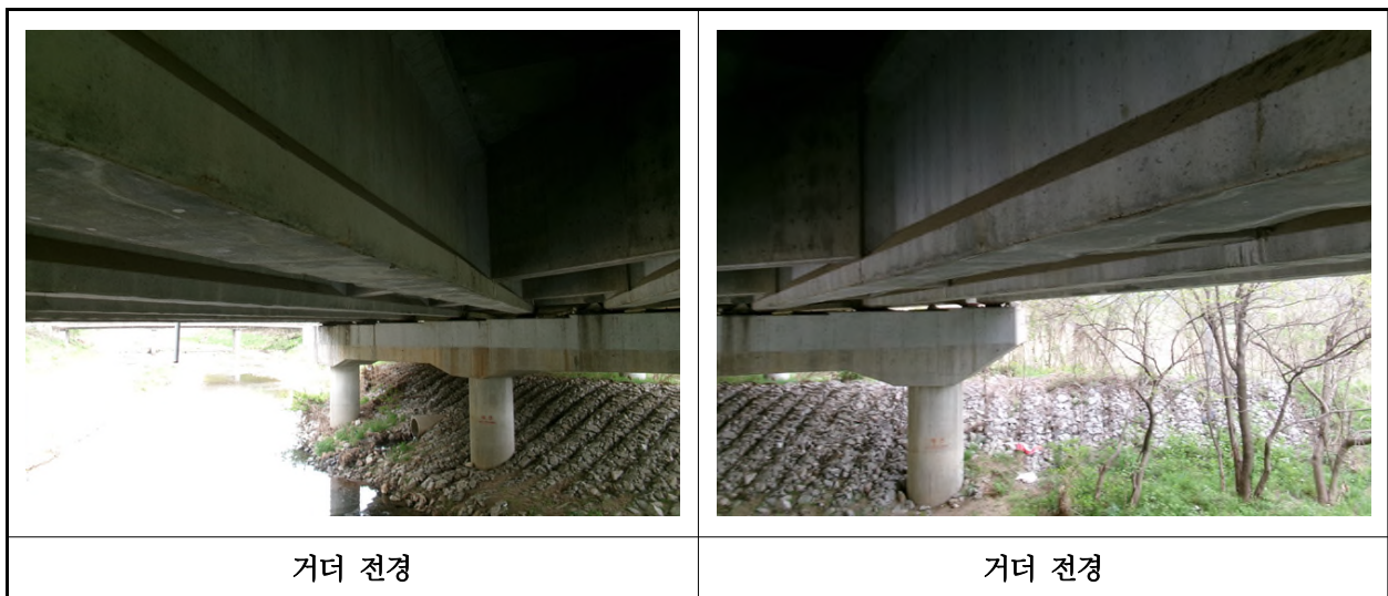
【사진 1.3.4】 거더 전경
