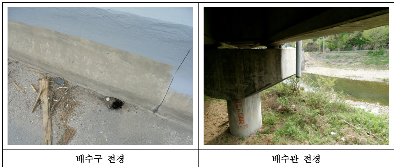
【사진 1.3.21】 배수시설 전경
