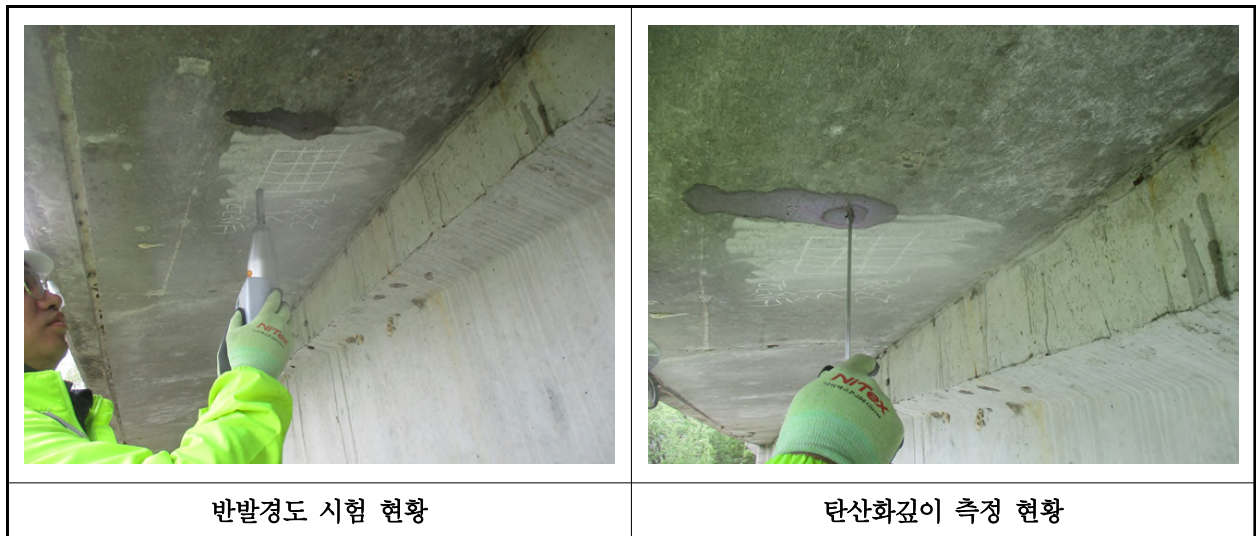
【사진 1.4.1】 콘크리트 내구성조사 현황
