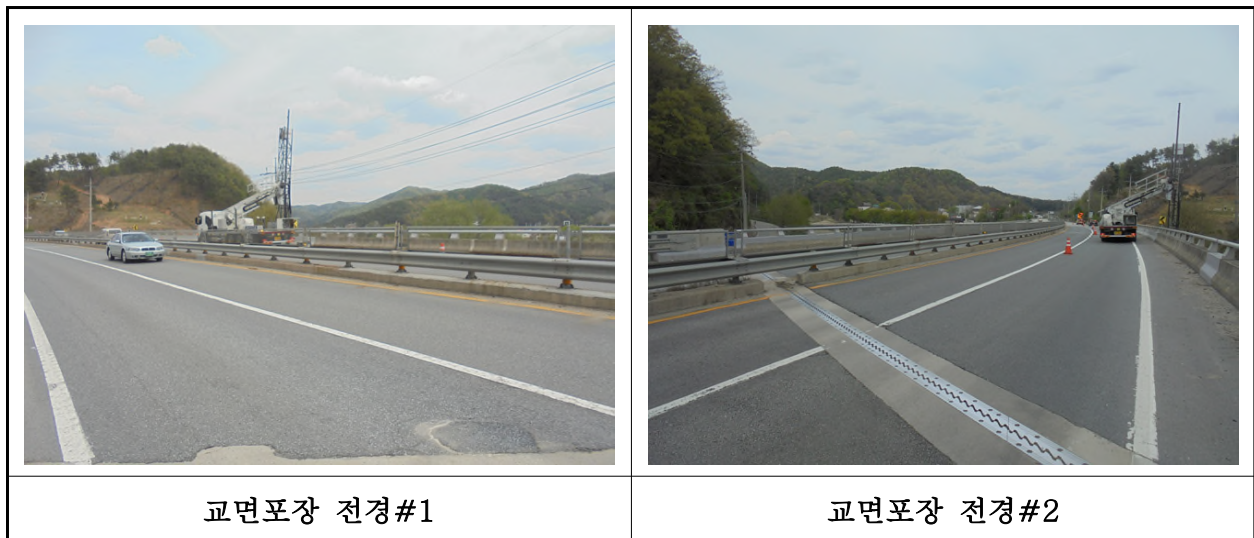
【사진 1.3.19】 교면포장 전경
