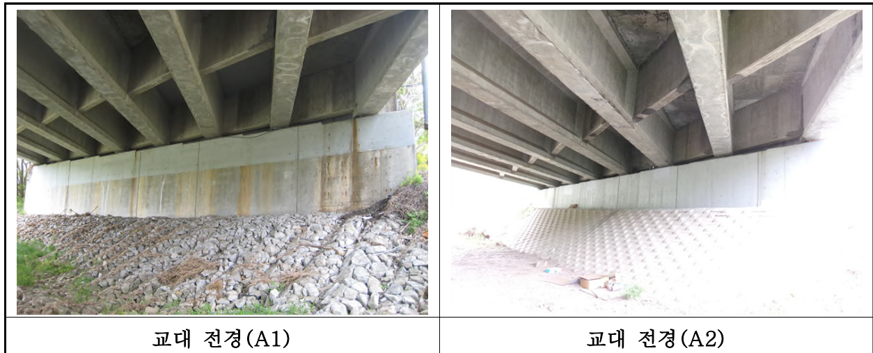
【사진 1.3.8】 교대 전경
