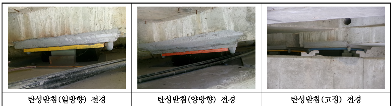
【사진 1.3.12】 교량받침 전경
